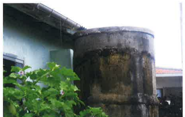
天水を溜めた水タンク
